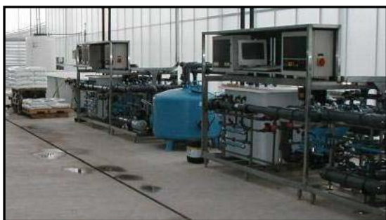
Station de pompage comprenant les sondes et l'ordinateur de contrôle
