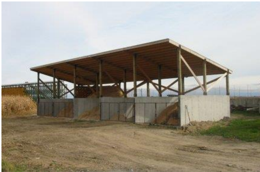
Figure 4. Exemple d'un bâtiment de compostage à 5 cellules
