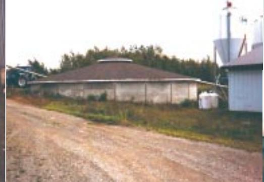
Réservoir constitué de demi-fermes triangulaires, de contreplaqué et de bardeaux l'asphalte.
