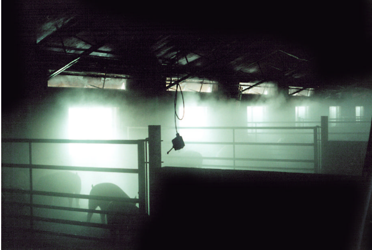
Figure 4. Problème de condensation en raison d'un manque de ventilation et/ou de chauffage en litière profonde
