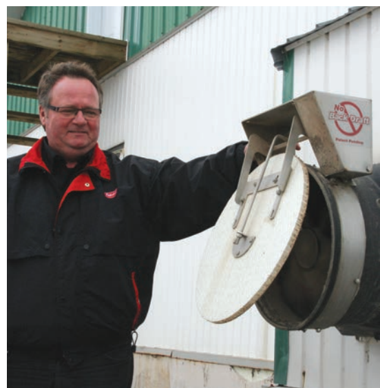
Ce volet anti-retour empêche tout retour d'air dans les ventilateurs. C'est un complément quasi-indispensable aux filtres antimicrobiens.
