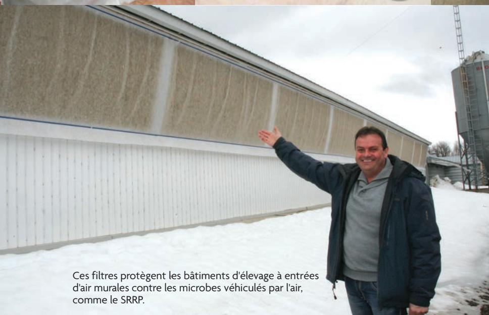
Dans les bâtiments ventilés par l'air passant par les combles, on a installé des filtres et des pré-filtres anti-microbes sur les entrées d'air.
