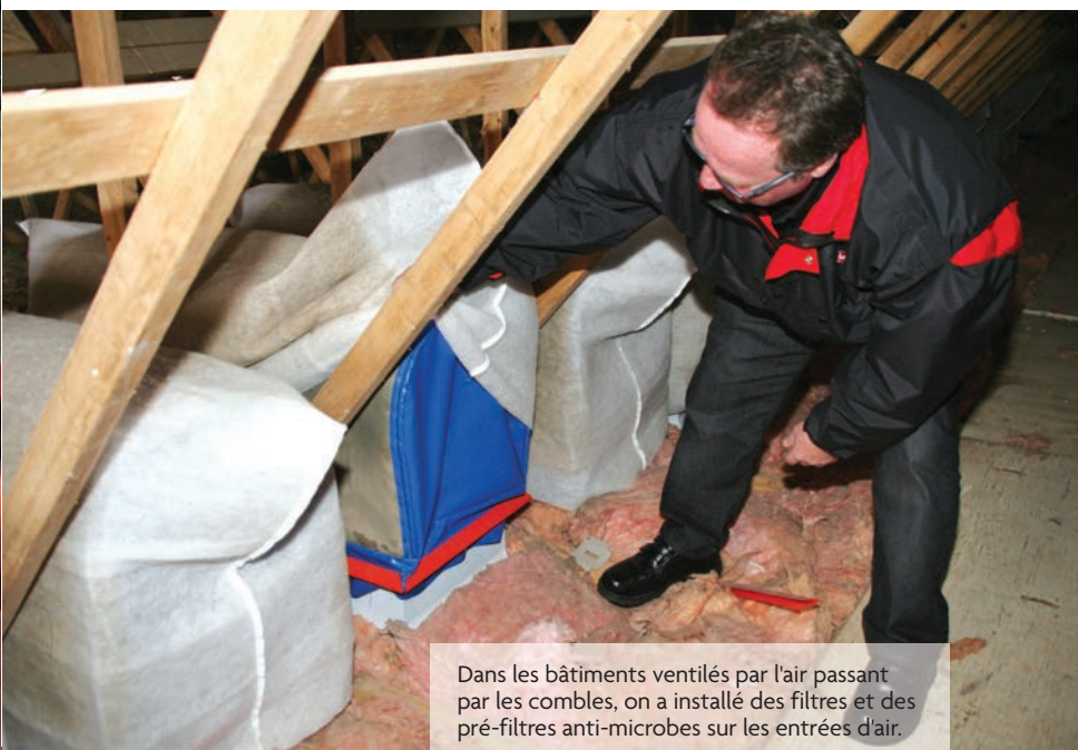
Ce volet anti-retour empêche tout retour d'air dans les ventilateurs. C'est un complément quasi-indispensable aux filtres antimicrobiens.
