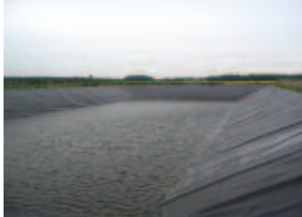
Cette lagune de 17 000 m 3 recueille l'eau épurée qui servira à irriguer les champs de foin.
