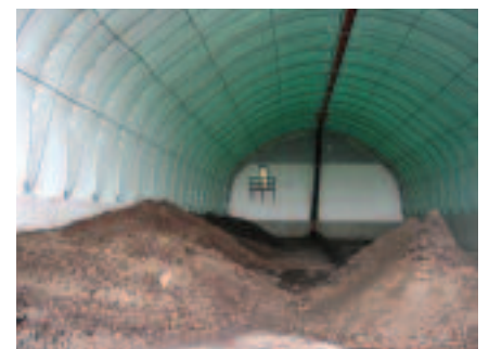
La fraction solide et traitée du lisier est entreposée dans cet immense abri.
