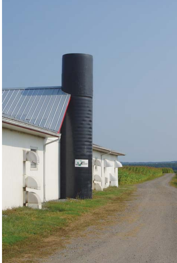
Deux bâtiments de la Ferme porcine Marnie sont équipés de cheminées qui propulsent l'air très haut et, par le fait même, les odeurs.
