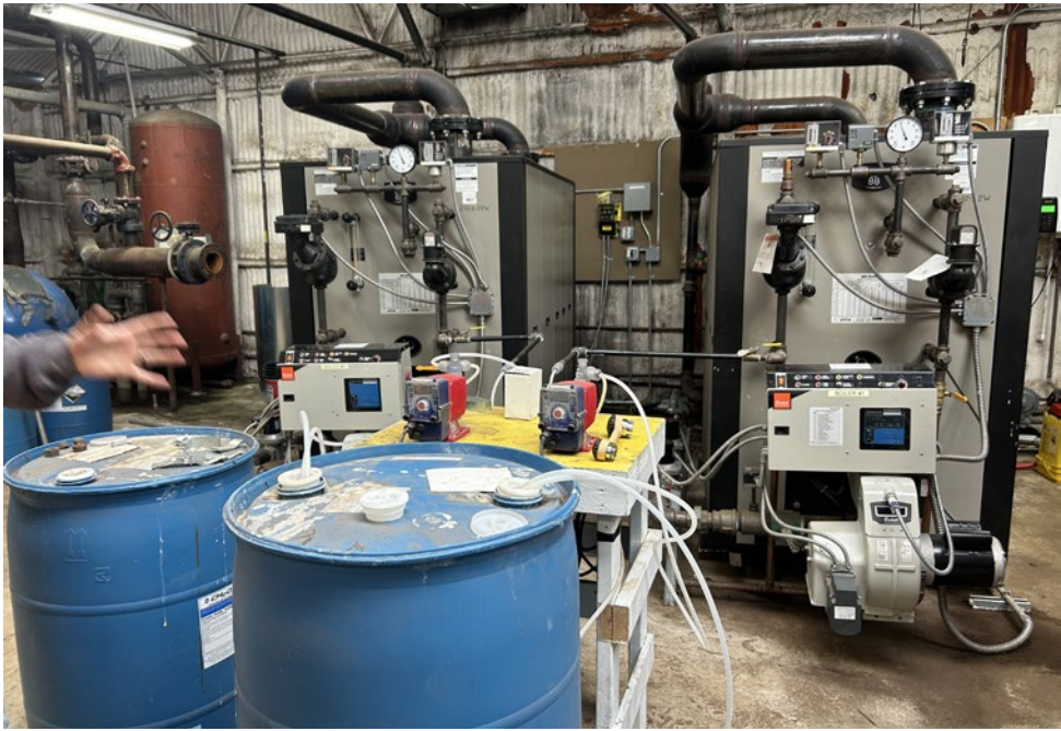
Salle de chaudière à vapeur (emplacement fixe), contrôle et traitement de l'eau
