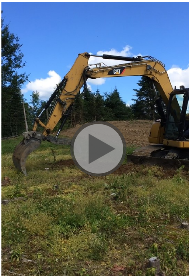
Vidéo 1. Enlèvement des souches avec une pelle mécanique
