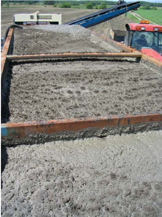
Problème de débordement causé par l'accumulation de mousse au réservoir tampon
